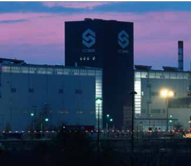
EKO Stahlwerk GmbH, Eisenhüttenstadt
